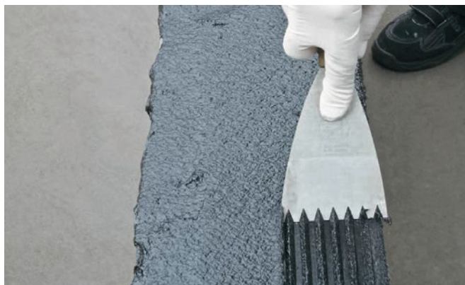
Enkolit® mit dem Rillenspachtel abziehen
