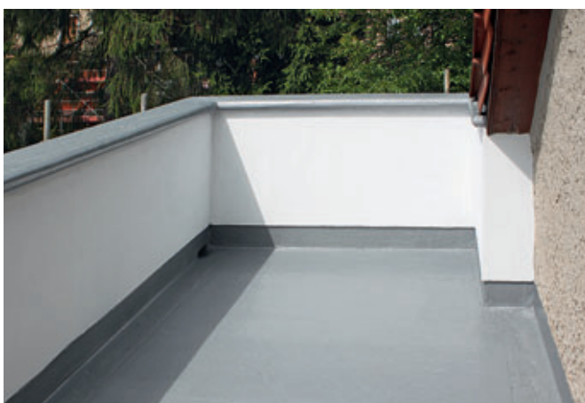
Terrassen und Balkonen
