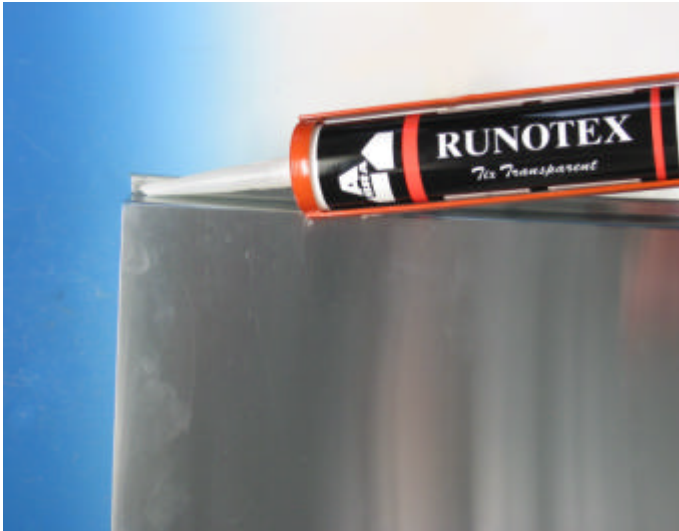
Bild 4: Aufbringung des Dichtmittels
